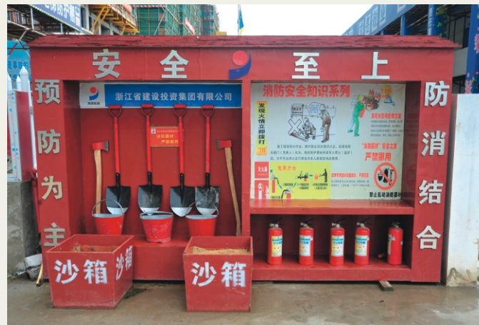
施工现场安全生产标准化配置
