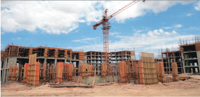
阿尔及利亚ORAN3100套公租房施工现场
