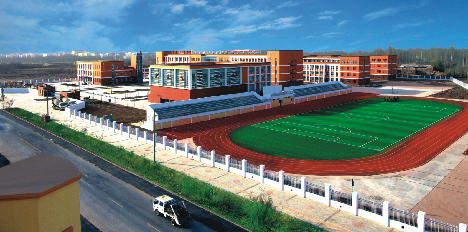
柯坪湖州双语小学被评为2012年度自治区安全文明工地，2013年度“天山杯”优质工程
